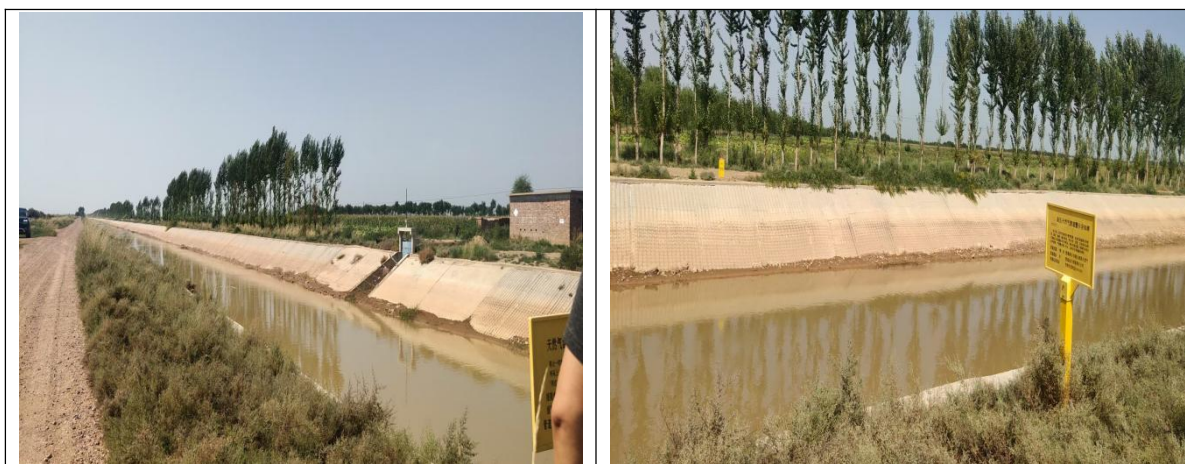
图 8.1-1 长济干渠穿越位置及现状
