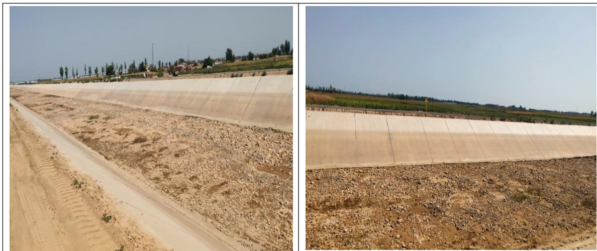
图 8.1-1 通济干渠穿越位置及现状
