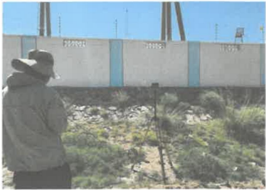
北侧西起第1间隔围墙外
