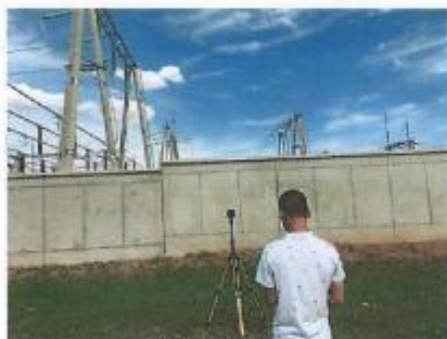
盐海 220kV 变西
