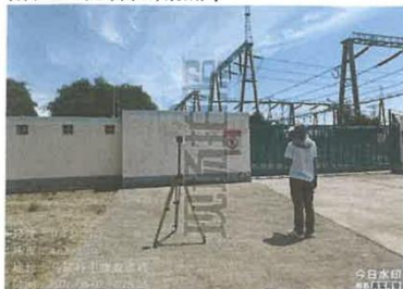
金泉 220kV 变电站西侧
