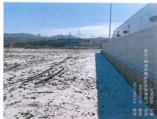
锦和变电站东北侧
