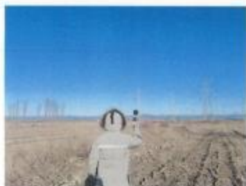
110kV 航野 I、II 线 14#-15#塔
