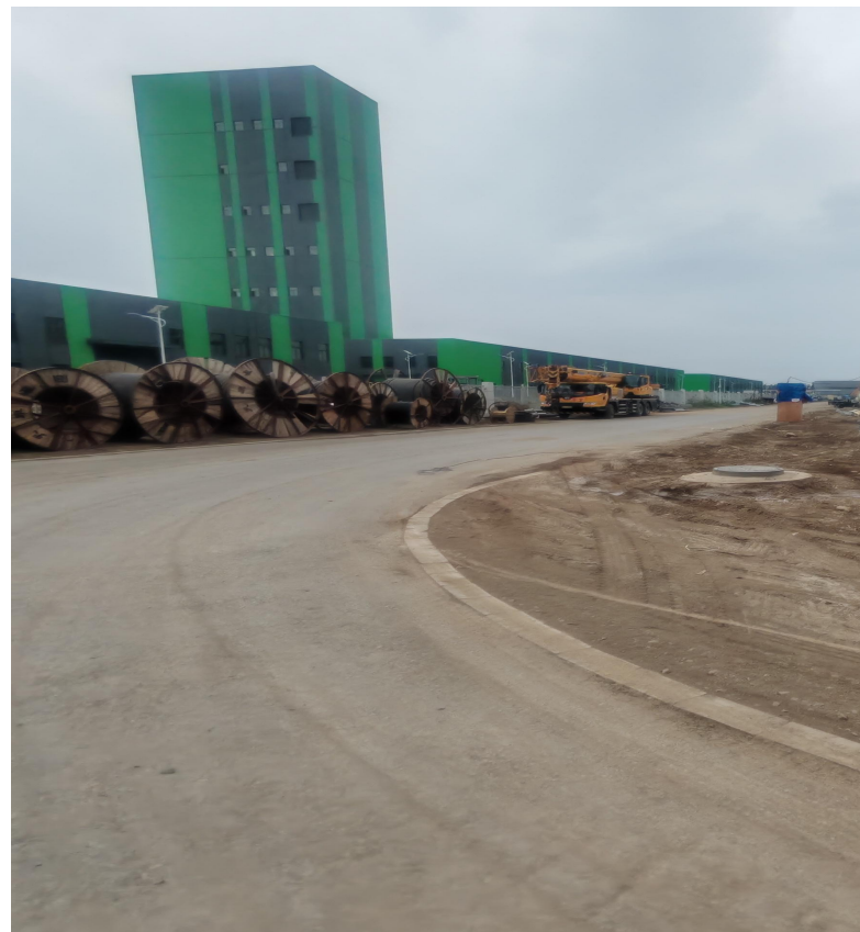
拟建变电站南侧 厂内道路
