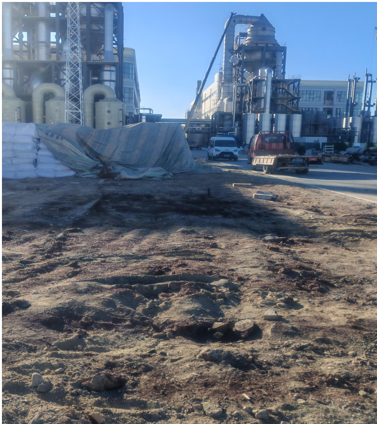
拟建变电站北侧 厂内空地
